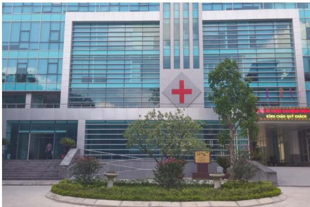
Hình ảnh 1: Khu toà nhà mới của Bệnh viện gồm 7 tầng nổi và 2 tầng hầm từ nguồn vốn ODA và ngân sách nhà nước
